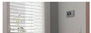
Für den Einsatz im Inneren des Raumes, in einer geschlossenen Doppelfassade oder in Kastenfenstern, eignen sich speziell geformte, hochreflektierende Jalousien. Mit ihren konkav geformten und verspiegelten Lamellen „schaufeln“ sie das Licht weit in den Raum. Gleichzeitig werden die Leuchtdichten in Fensternähe reduziert. Der Raum ist so gleichmäßig und blendfrei mit Tageslicht ausgeleuchtet.
